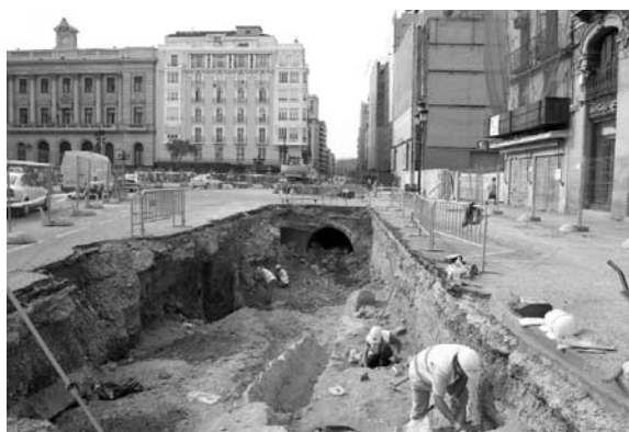
Vista general: Proceso de excavación en Sector I.
