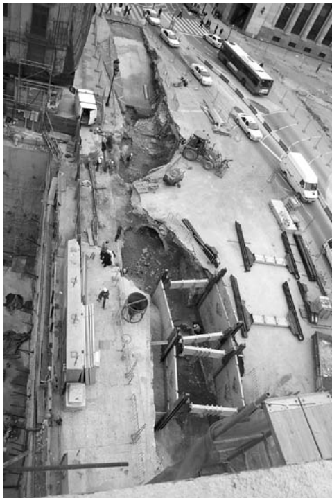
Panorámica del área de excavación.
