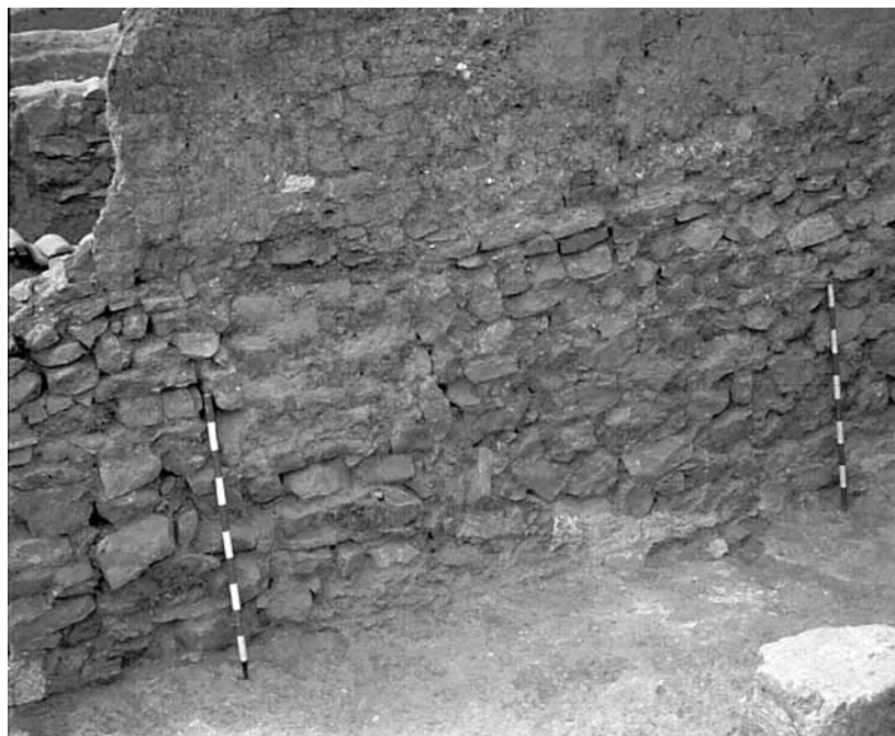
Figura 3. Opus vittatum con recrecimiento de adobe, muro T.
