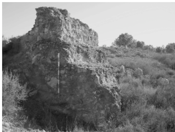
Foto 5. Restos conservados de una presa.
