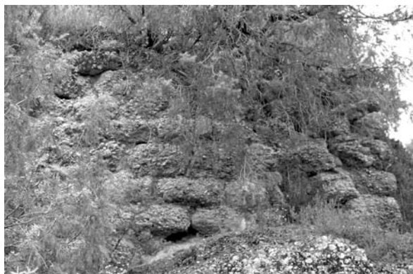
Lámina 18. restos de la muralla de sillares de conglomerado de la fortaleza denominada "Castiello" (término de Secastilla, Huesca), identificado tradicionalmente como "Castro Muñones". Obsérvese el aparejo de sillares de gran módulo, con bloques extraídos del propio sustrato rocoso, de aspecto muy similar al de las murallas de castillos de origen islámico de la zona como Ager (Lérida) o La Mora (Peralta de la Sal, Huesca) entre otros.
